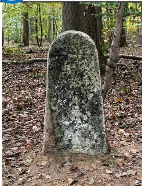
Cette borne avait été déterrée et couchée sur le sol. Elle a fait l'objet d'une remise en place lors de la campagne de redressement des bornes en novembre 2023. Sa position a préalablement été définie par un géomètre en prenant en compte les autres bornes. On voit bien aujourd'hui l'alignement des quatre bornes qui se suivent.
