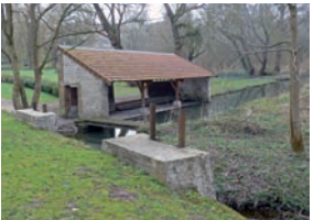
Le lavoir et les vannes d'inondation
